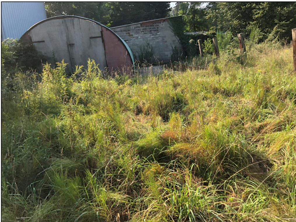
Foto 17: Hoek oostzijde locatie kijkend naar Romneyloods. Datum foto: 16 september 2020
