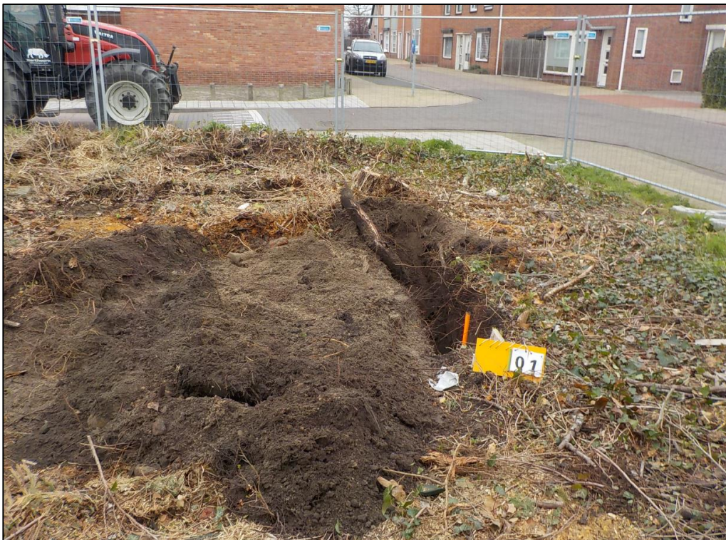
Foto FA12: Asbestinspectiesleuf SL1
