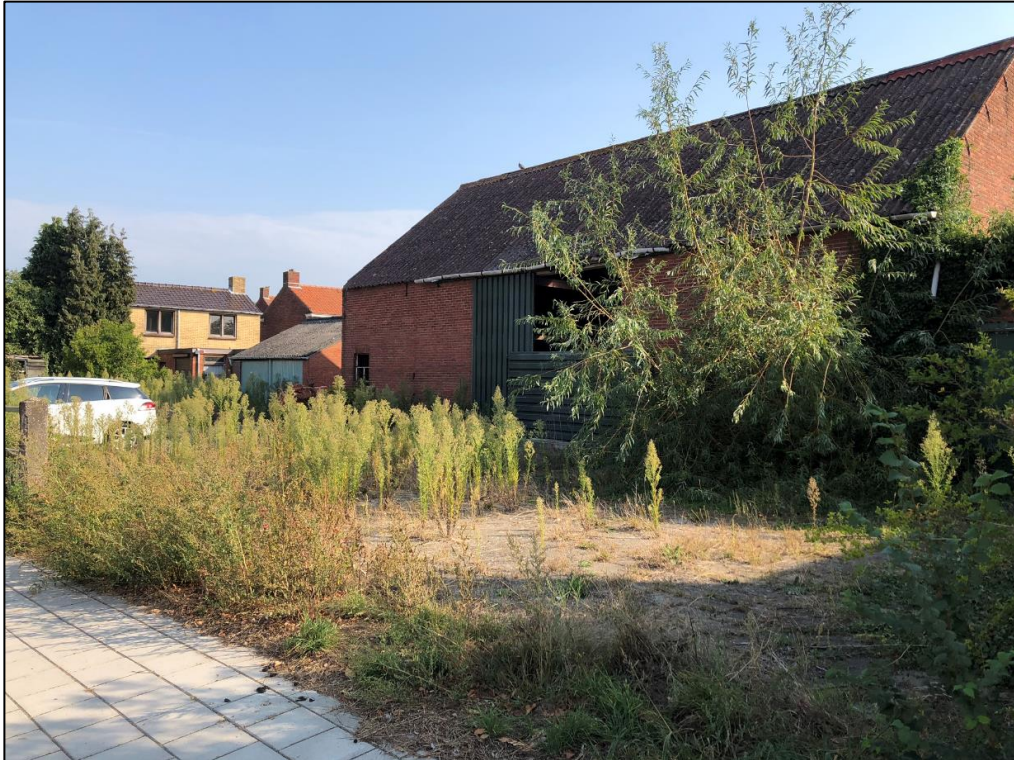
Foto 11: Vooraanzicht schuur westzijde. Datum foto: 16 september 2020
