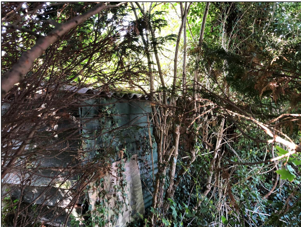
Foto 15: Achterzijde (noordkant) vervallen schuurtje. Datum foto: 16 september 2020
