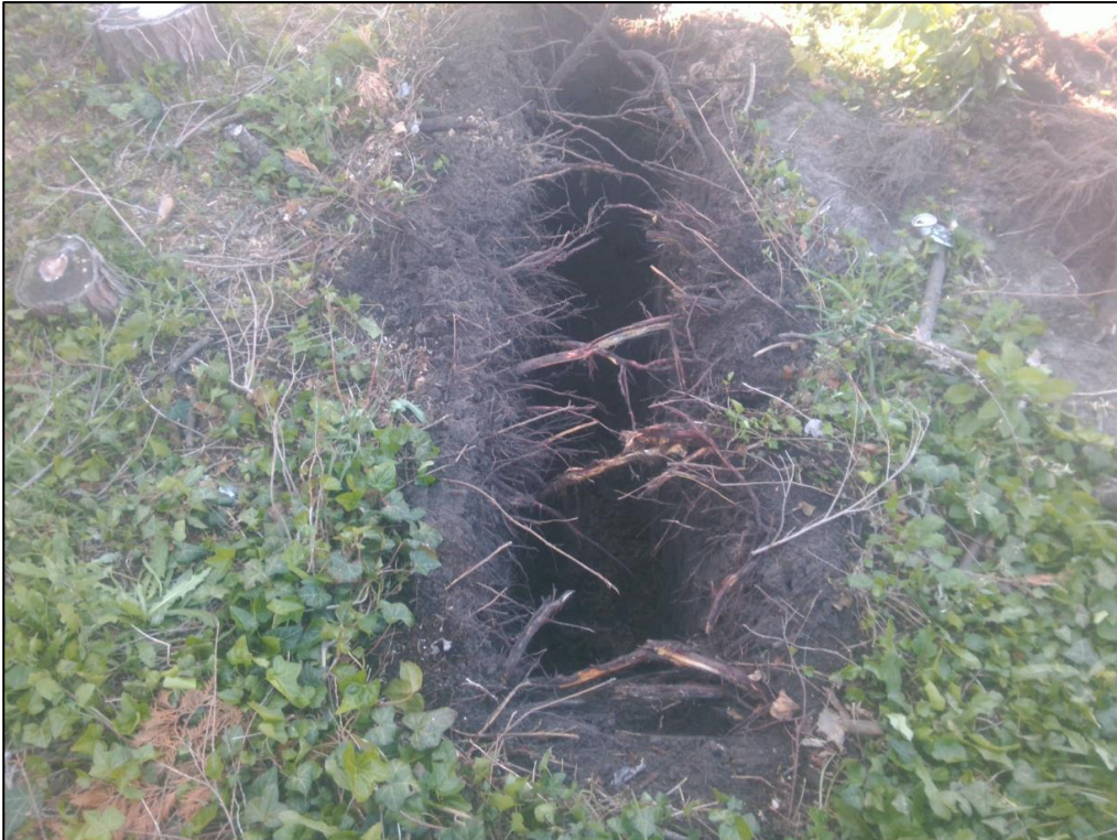
Foto 3: Asbestinspectiesleuf SL101
