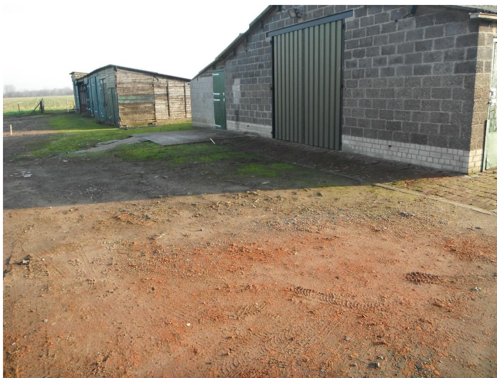
Foto 4. Erfverharding bestaat uit puin
