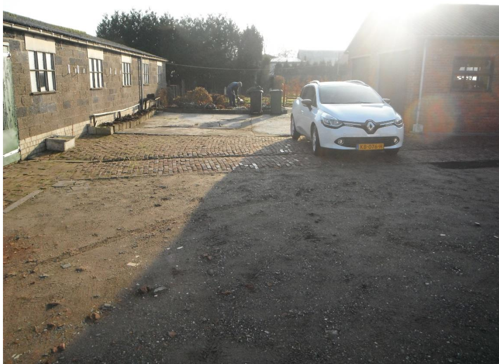
Foto 3. erfverharding bestaat uit puin en klinkers
