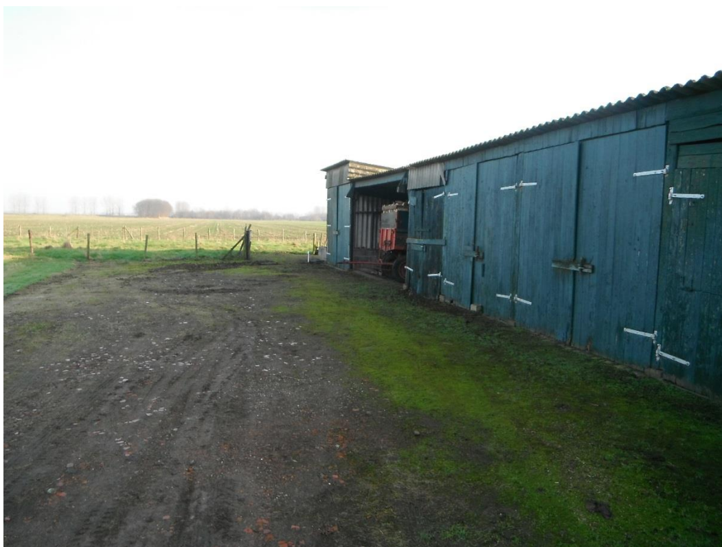
Foto 7. Erfverharding bestaat uit puin
