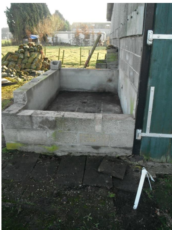
Foto 8. Voormalige bovengrondse tank
