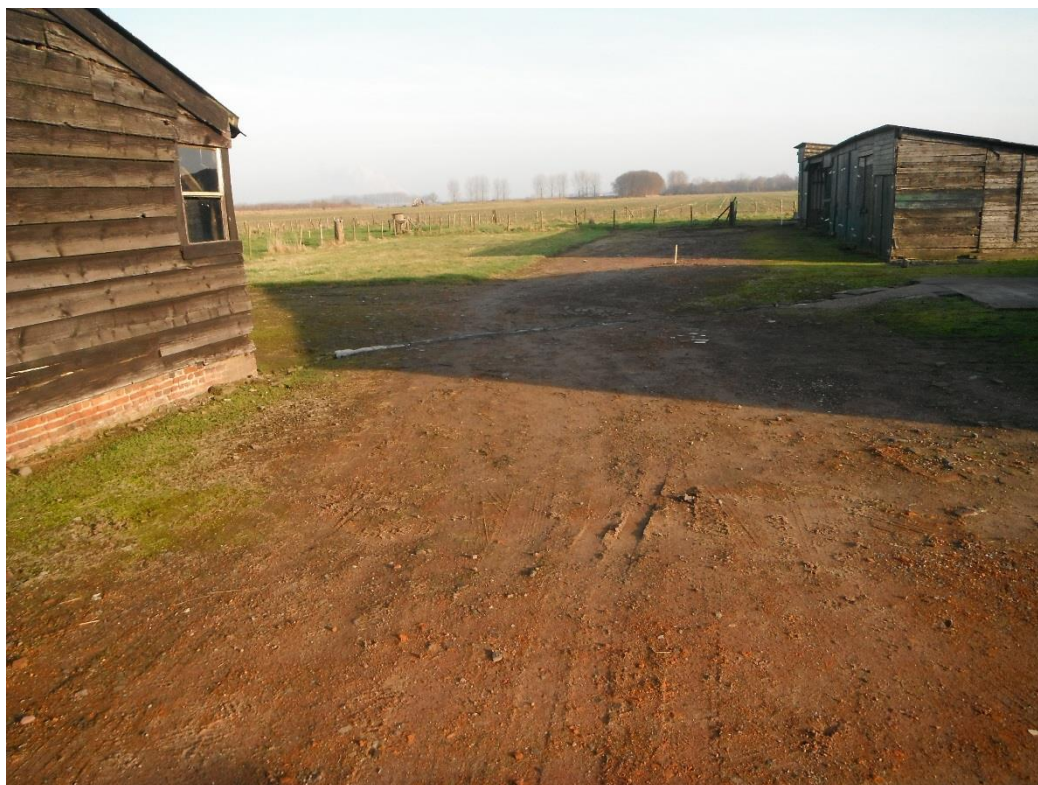
Foto 5. Erfverharding bestaat uit puin
