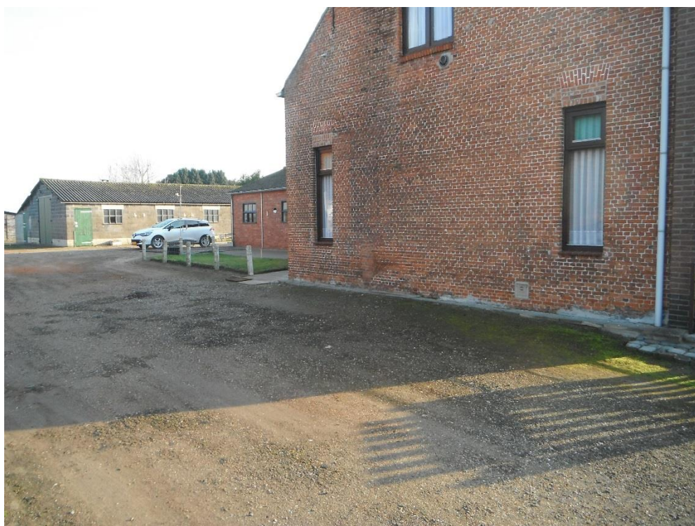
Foto 2: Erfverharding bestaat uit puin
