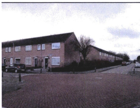
Foto 3: woning op hoek Frans Halsstraat/Rembrandtstraat. Zijgevel potentieel geschikte locatie voor plaatsen van een vleermuizenkast
