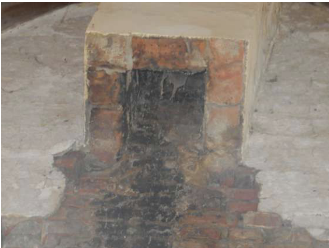
Foto 1 Schoorsteen van het pand, geen asbest waargenomen
