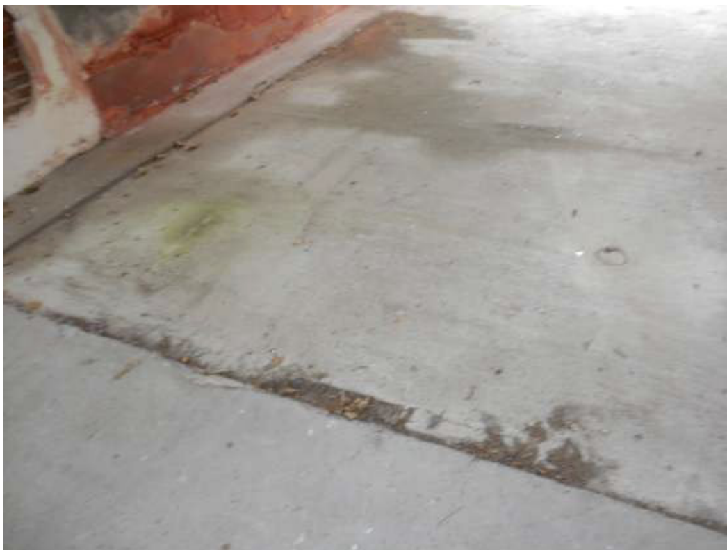
Foto 4 Begane grondvloer van woning: geen asbest aangetroffen
