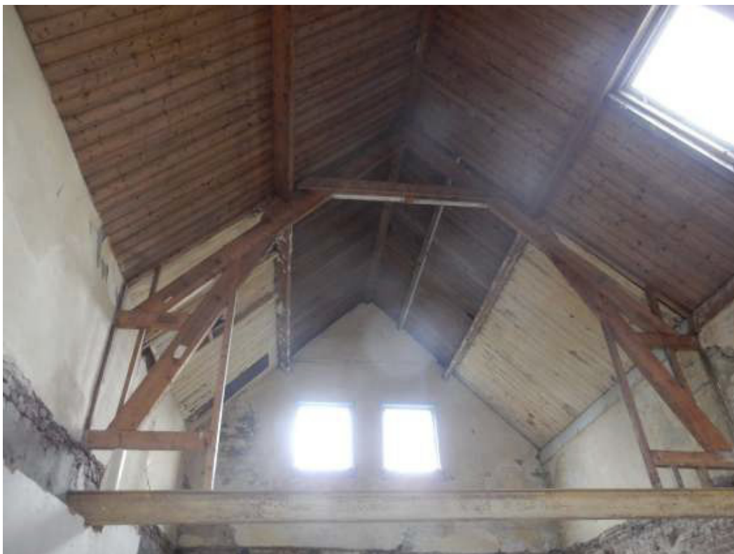
Foto 2 Dakbeschot met raamopeningen: geen asbest aangetroffen
