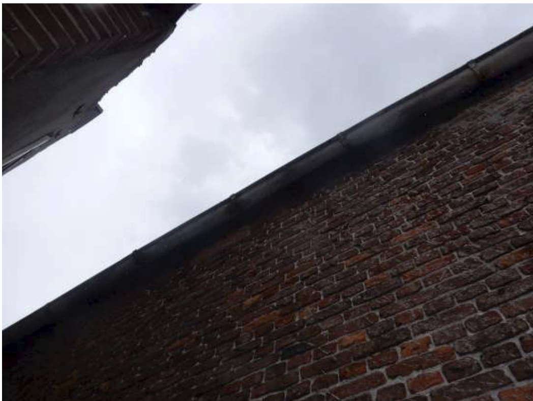
Foto 5 Dakgoten van voormalige woning: geen asbest aangetroffen
