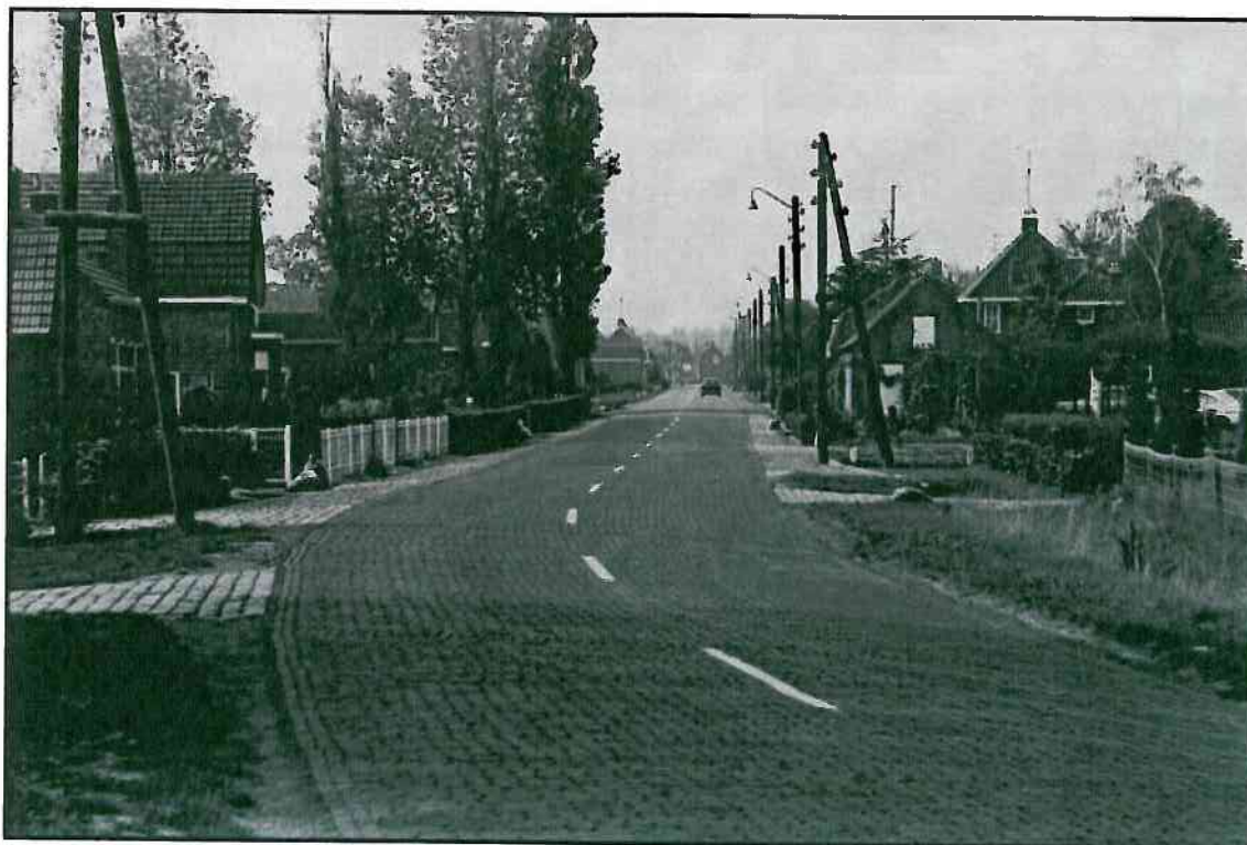
Figuur 18: Lintbebouwing langs de Julianastraat in de richting van Koewacht aan het begin van de 20 e eeuw (Bron: Beeldbank Zeeland, 2011)
