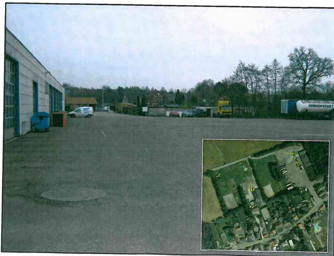
Foto 4: Gezicht over het verharde deel van het terrein van Volvo Truck Garage Kant. De kijkrichting is zuidoostelijk. De locatie en oriëntatie van alle foto's zijn opgenomen in het inzetje rechtsonder.
