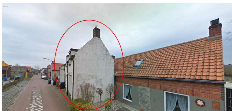
figuur 1.3c foto-impressie te slopen woning (foto gedateerd)
