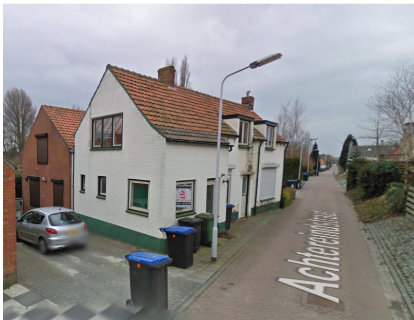
figuur 1.3b foto-impressie te slopen woning (foto gedateerd)
