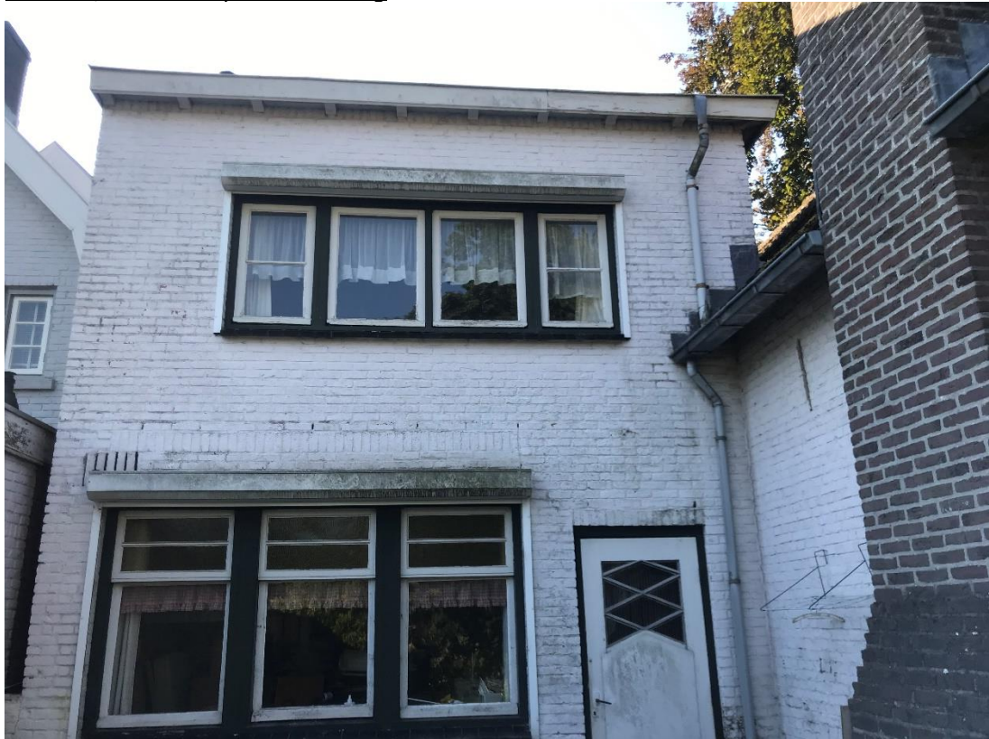
Foto 1. t/m 3. Te slopen bebouwing
