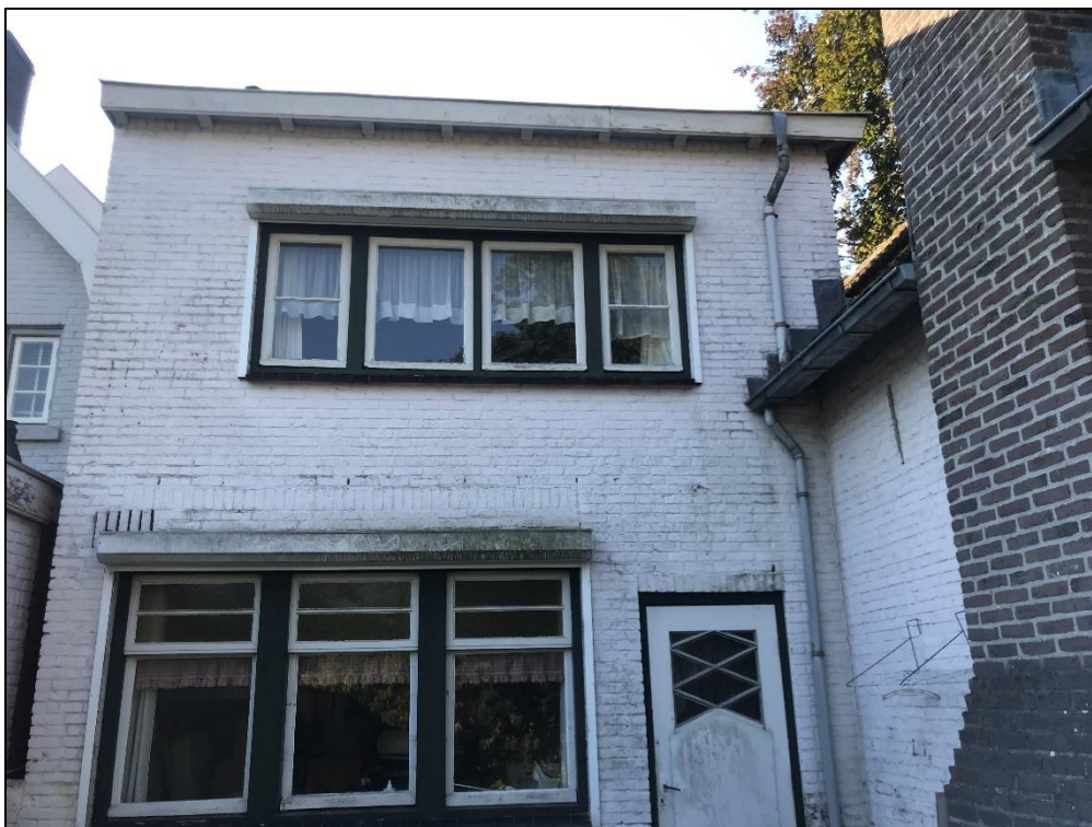
Afbeelding 2.3, achterzijde te slopen woning aan de Wilhelminastraat 20 te Sint-Jansteen
