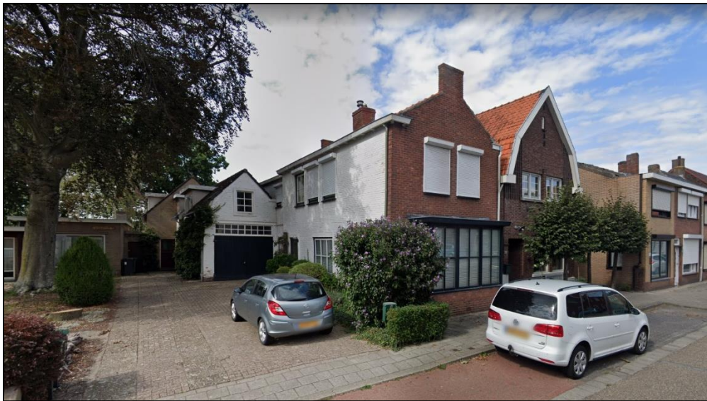
Afbeelding 2.2, te slopen woning aan de Wilhelminastraat 20 te Sint-Jansteen
