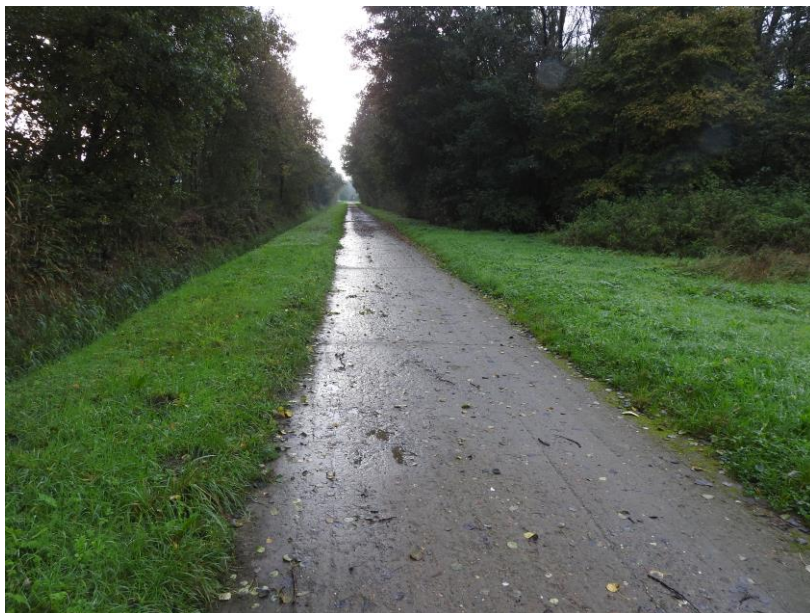
Foto 1. Bestaand te gebruiken fietspad.
