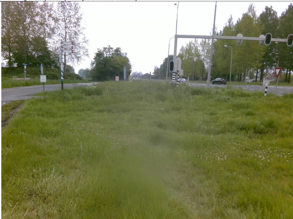
Foto 2: bermen tussen Parallelweg West en Rondweg Hulst (N290)
