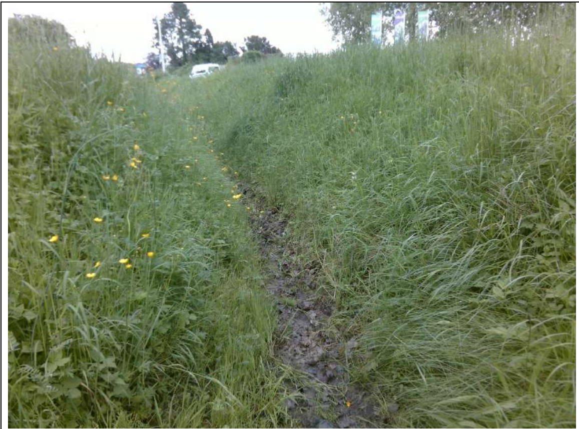
Foto 9: Te dempen sloot oostzijde locatie
