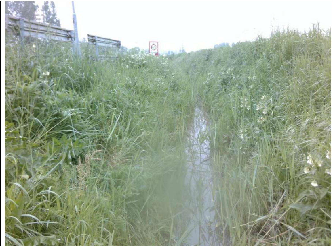
Foto 11: Te dempen sloot westzijde locatie
