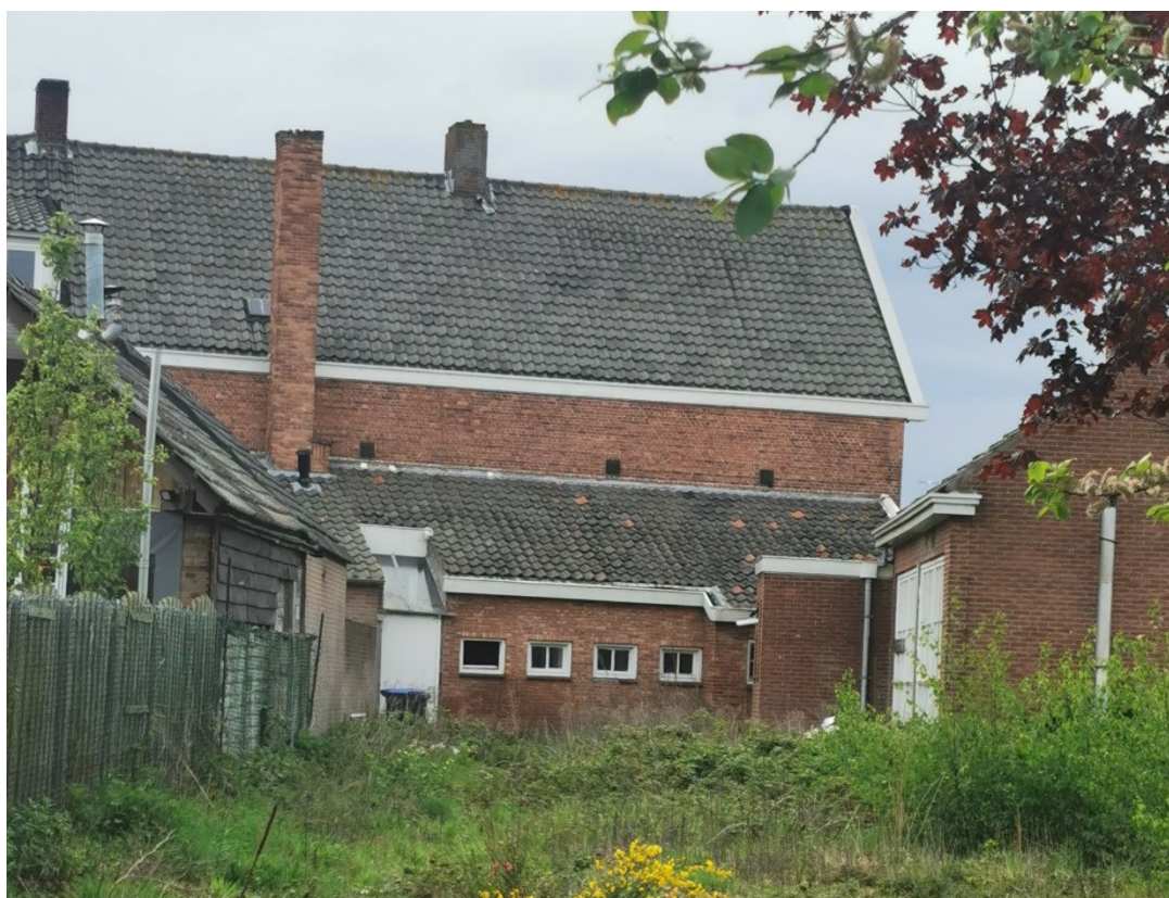
Figuur 6. Bestaande situatie achterzijde
