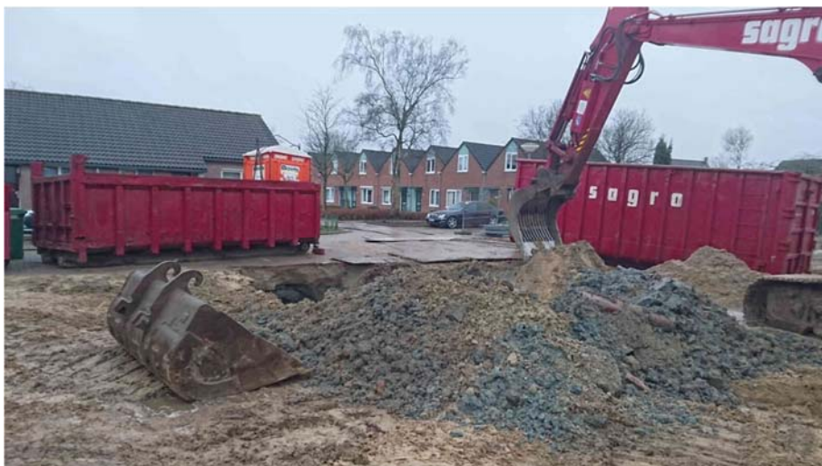
IMG_2030. Locatie voormalige HBO-tank na verwijdering.
