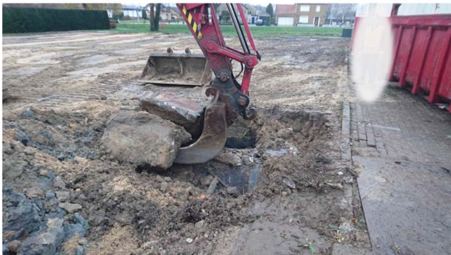
IMG_2009. Ondergrondse HBO-tank direct voorafgaand aan verwijdering.
