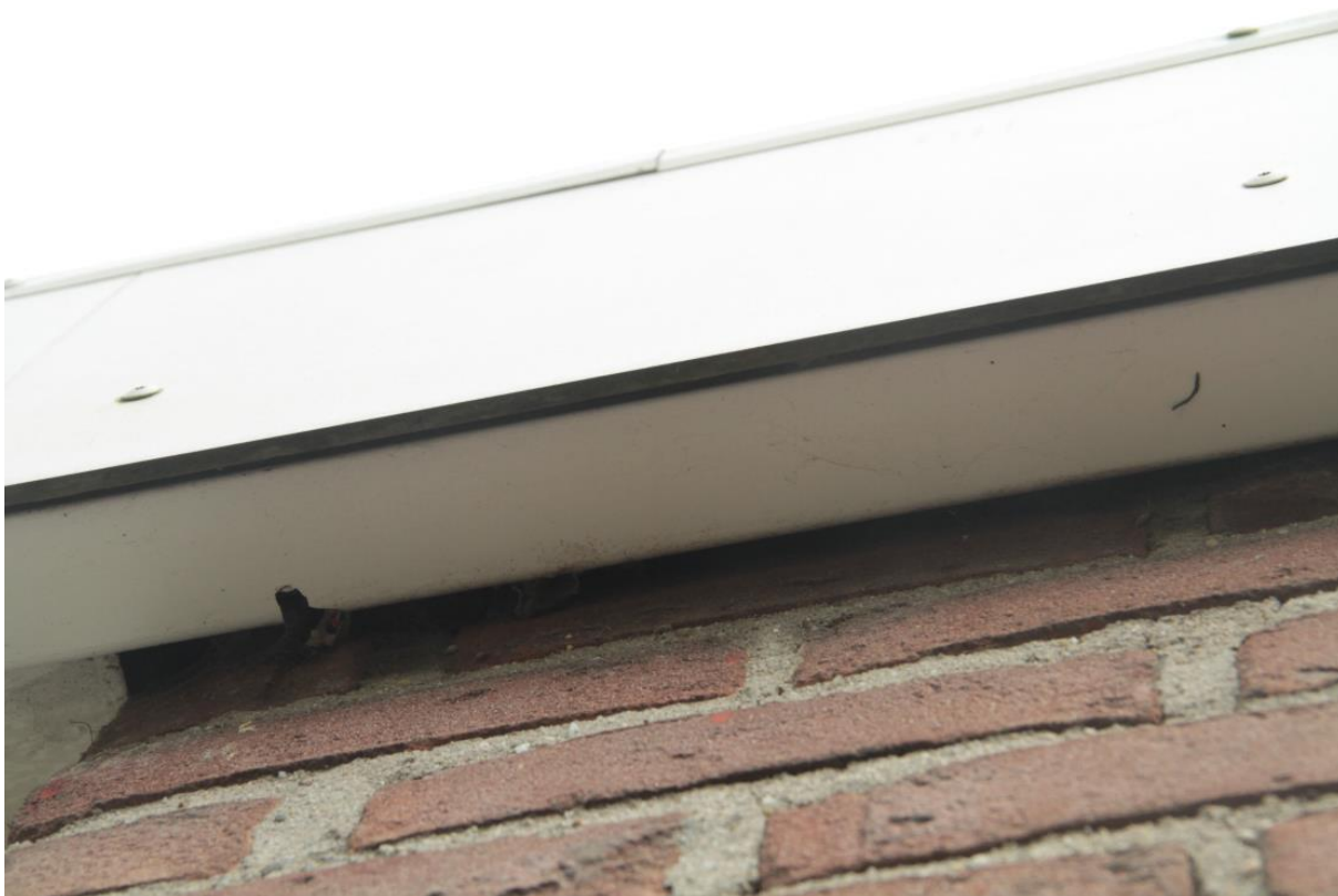
Potentieel dagverblijf vleermuizen in te slopen gymzaal
