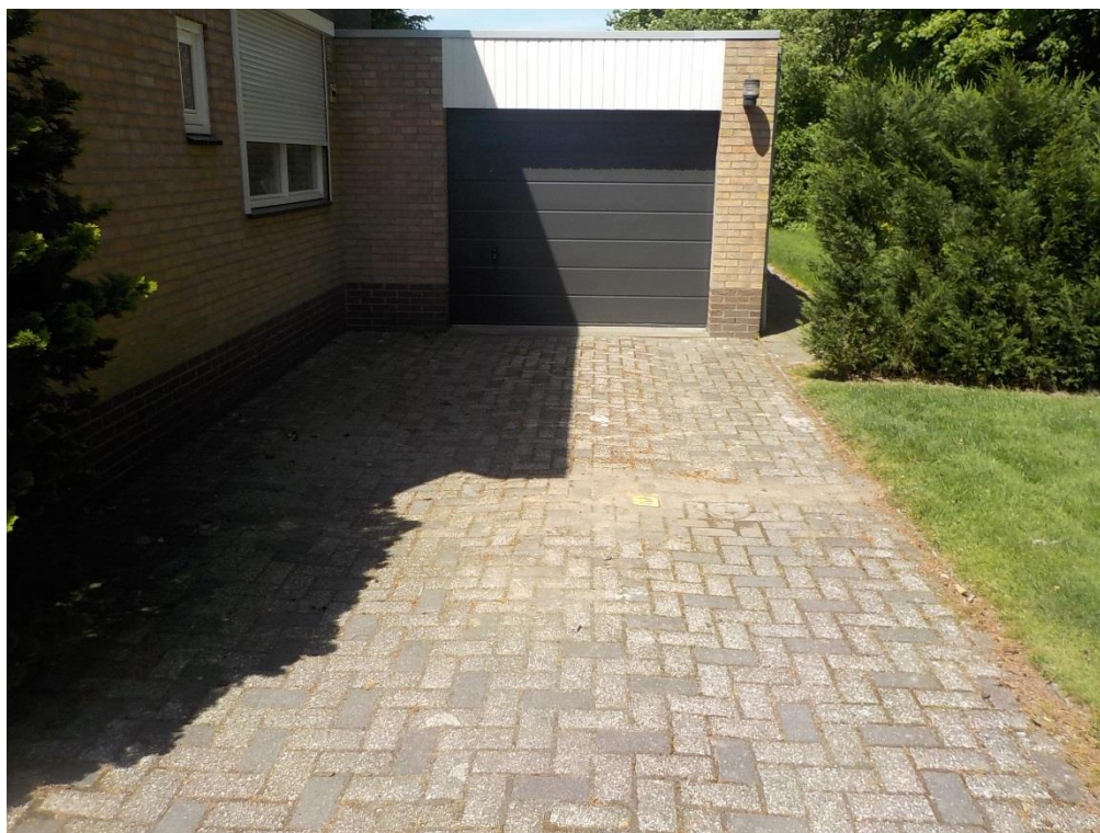
Foto 3. Garage naast woonhuis
