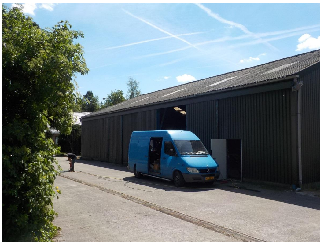
Foto 7. Erfverharding bestaat uit beton
