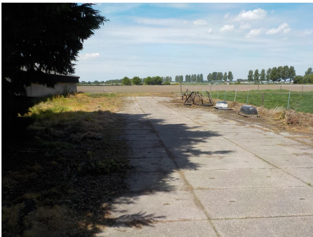
Foto 10. Verharding bestaande uit stelconplaten
