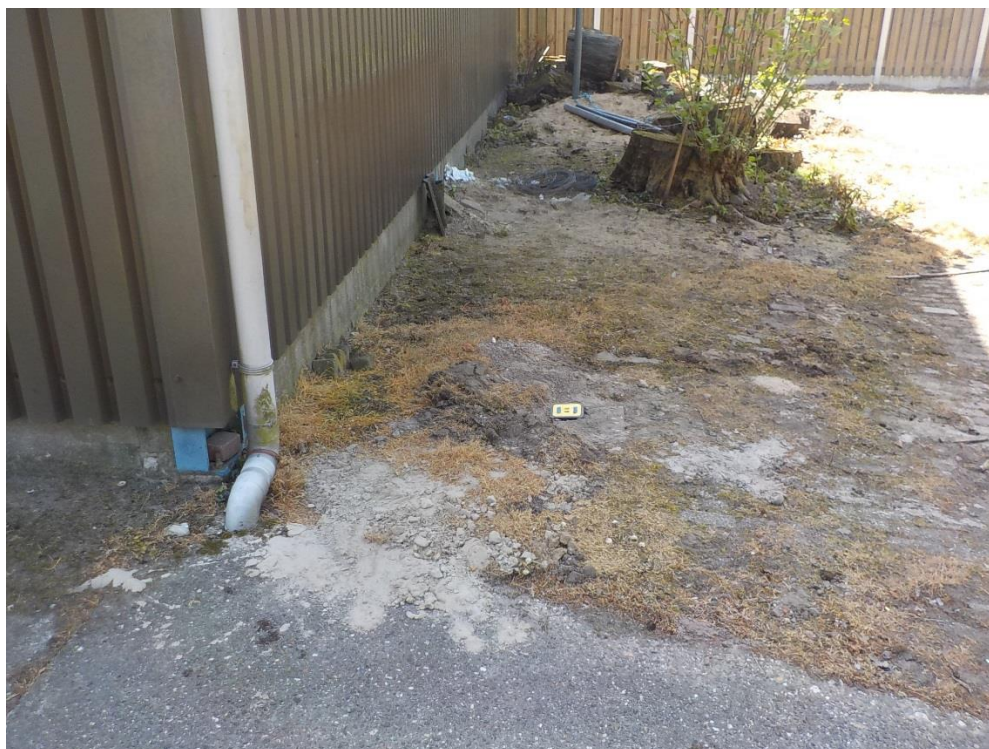
Foto 1 Peilbuis 1 ter plaatse van voormalige bovengrondse dieseltank
