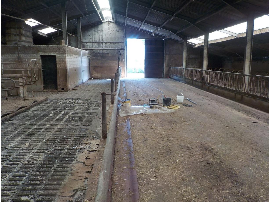
Foto 13. Stallen met betonvloer
