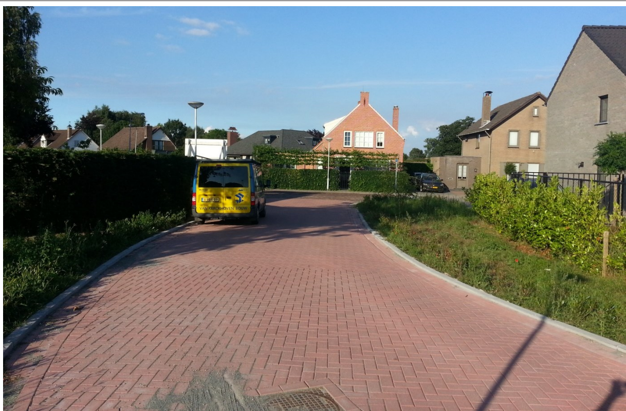
Figuur 8. Aansluiting op de Brouwerijstraat (augustus 2013)
