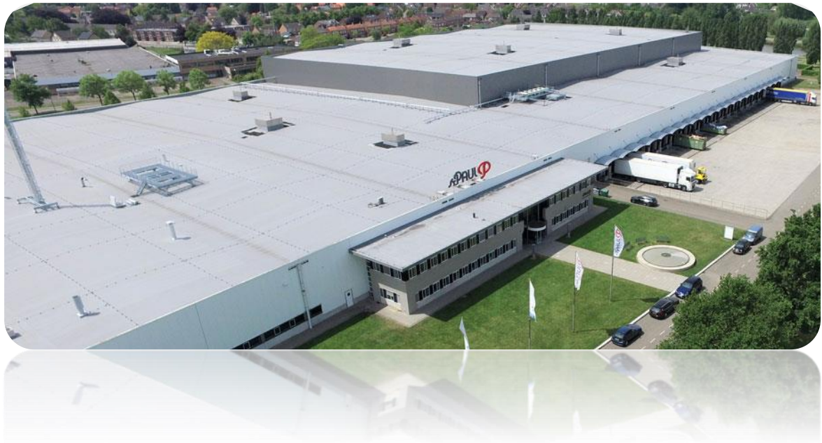
Figuur 10. - technische installaties op het dak
