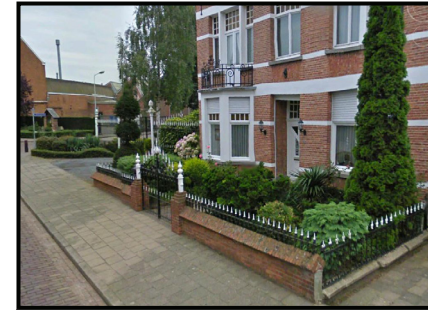
Lage tuinmuur, gecombineerd met hekwerk en groene voortuin
