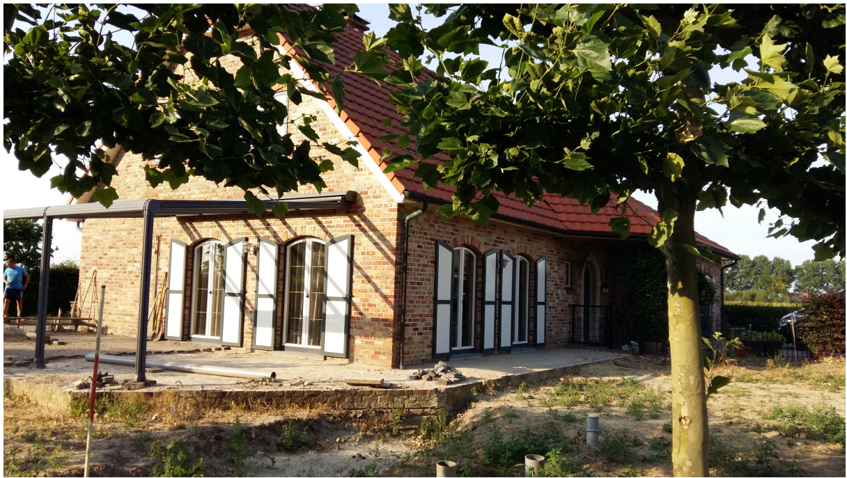
figuur 1.3g impressie aanwezige bedrijfswoning
