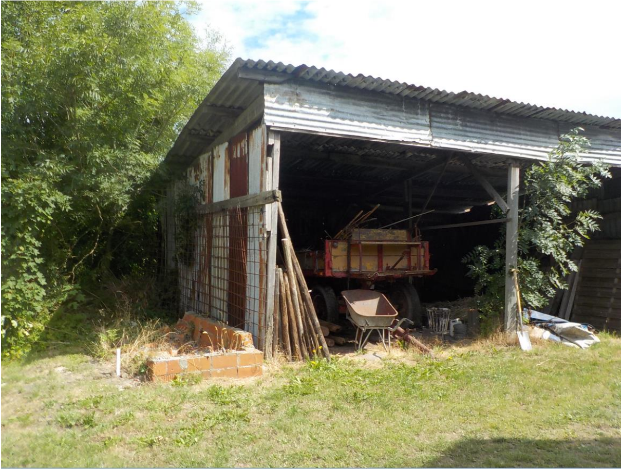
Locatie voormalige bovengrondse dieseltank (peilbuis 19)
