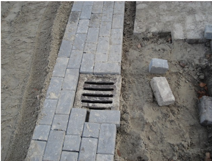
Figuur 12 Molgoot met straatkolk klinkers
