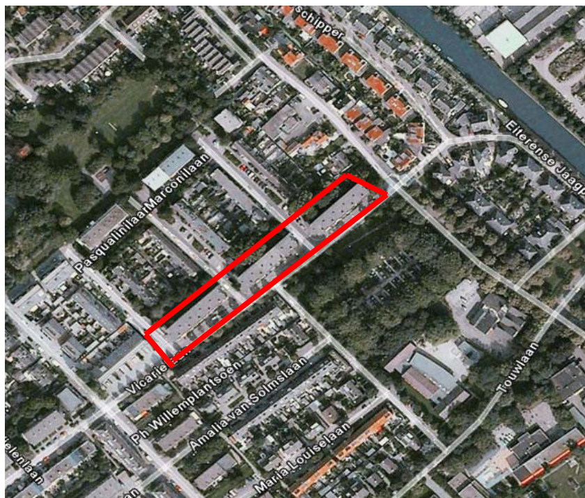
Figuur 1: luchtfoto planlocatie
