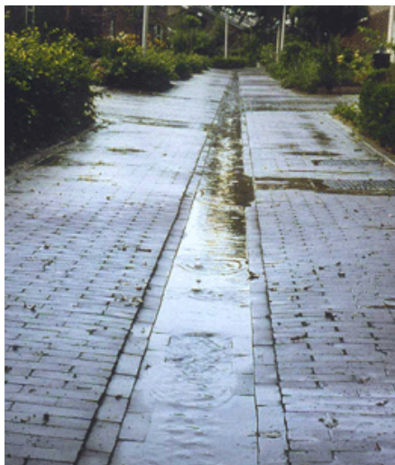
Figuur 10 en 11 Molgoot klinker en molgoot beton
