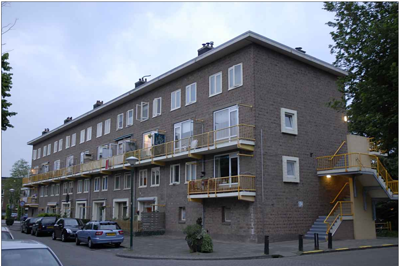
Vicarielaan, zuidelijkst gebouw.
