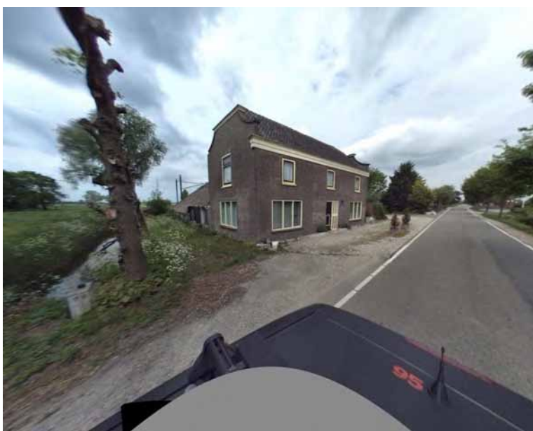
Figuur 2.1 Bestaande woning. (bron: Cyclomedia).
