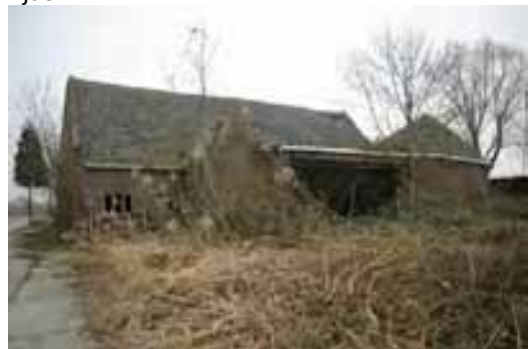
Figuur 6 Ontoegankelijke grote schuur met omliggende bramenveld
