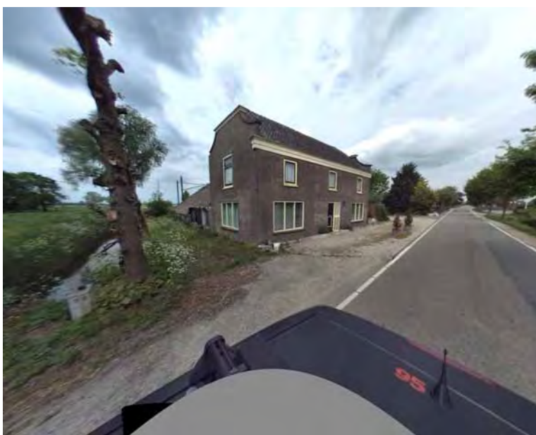
Figuur 2.1 Bestaande woning. (bron: Cyclomedia).
