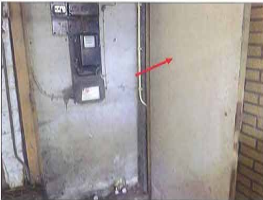
Foto 4: Item C: Plaat op deur meterkast
