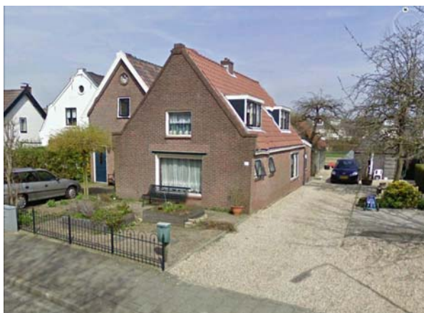
Voorzijde bestaande woning
