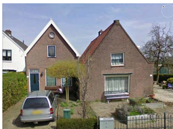
De aansluiting met woning nr. 61
