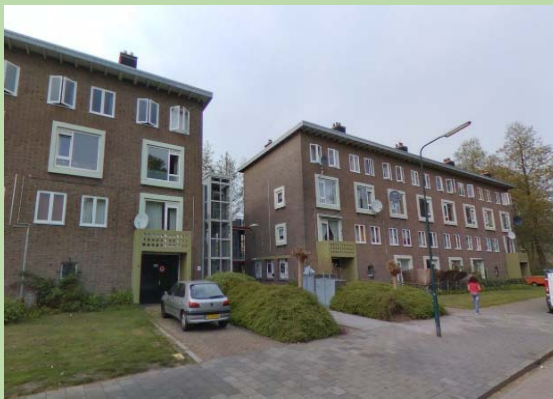
Figuur 2.1 Deelgebied 1: de flats aan de Anna van Buren straat
