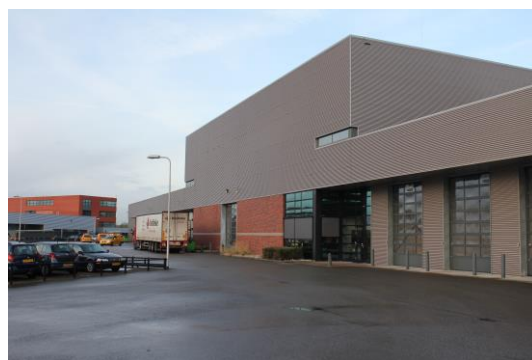
Bedrijfsgebouw van voorheen Terberg.
