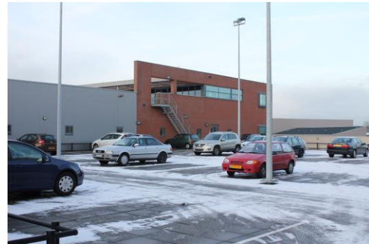
Parkeerdek op bestaand bedrijfsgebouw.
