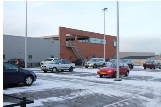
Parkeerdek op bestaand bedrijfsgebouw.
