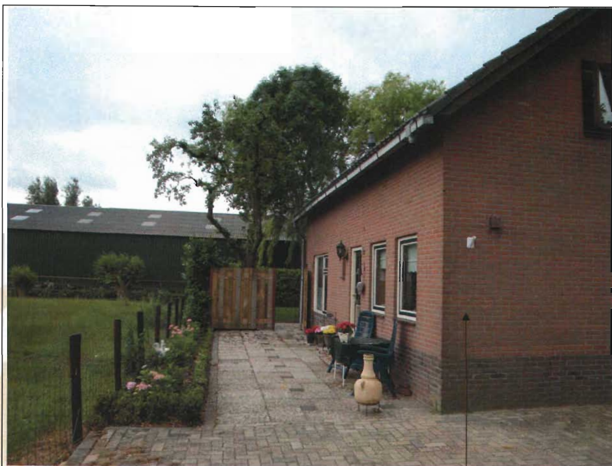
Schuur firma Kool, nokhoogte ca. 7 m
