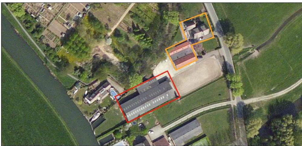
Afbeelding 2.3: Te slopen en te behouden bebouwing in het plangebied (Bron: Arcgis)
