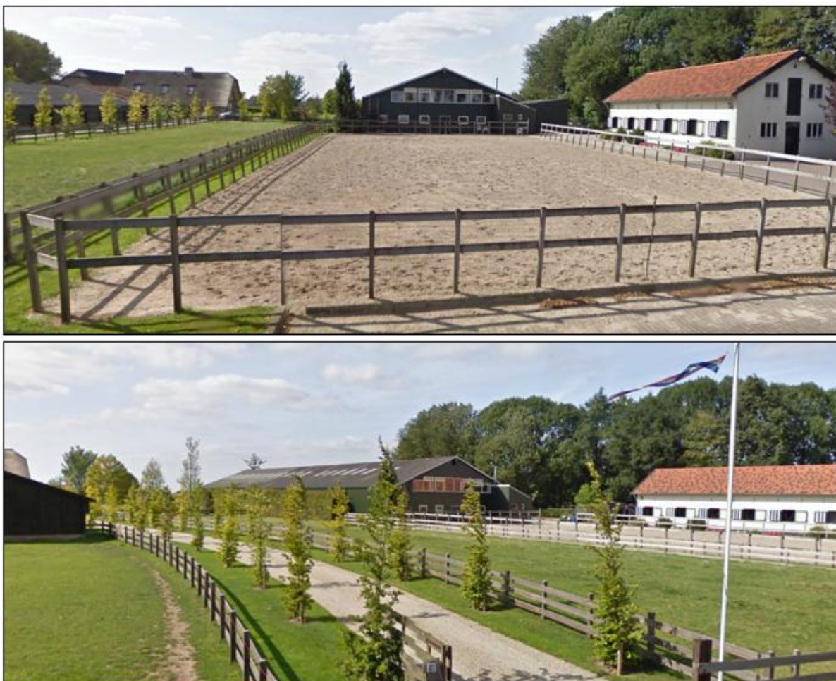
Afbeelding 2.2: Straatbeelden van de binnenmanege (Bron: Google streetview)
