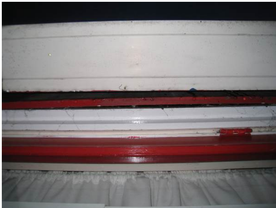
Figuur 2: Spleet met spinrag aan voorgevel kantine
