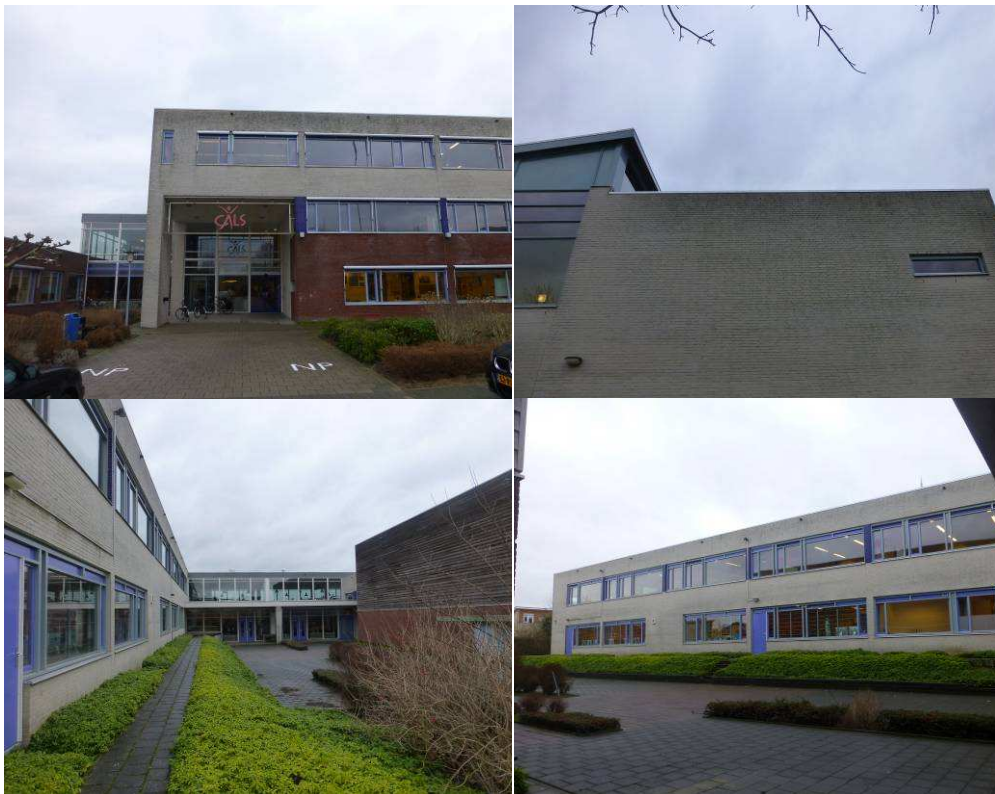
Figuur 5. Impressie gebouw in het plangebied. De uitbreiding van de school zal worden aangesloten op de linksboven weergegeven ingang. Het gedeelte weergegeven op de foto rechtsboven en rechtsonder en het lage gedeelte weergegeven in de foto linksonder worden verhoogd.
