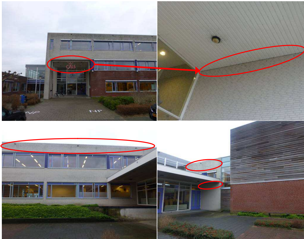
Figuur 6. In de delen van het gebouw waar aanpassingen plaatsvinden (uitbreiding (boven) en verhogen (onder)) zijn open ruimtes en spouwmuurgaten aanwezig die in potentie geschikt zijn als vaste rust- en verblijfplaats voor vleermuizen.
