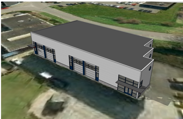
Bestaande toestand in vogelvlucht
