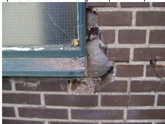
Foto 2: Hal E, detail raamconstructie met asbesthoudende kit daar waar het raamkozijn op de constructie is vastgezet (zie AVH2).
