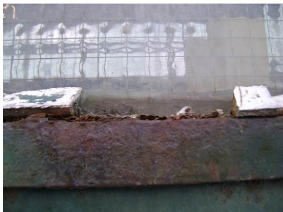
Foto 1: Hal E, de beglazingskit is als asbestvrij beoordeeld (zie M3 op analysecertificaat 10.25609-19 in bijlage 2).
