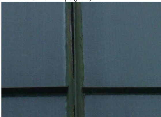
Foto 1: Hal E, de beglazingskit is als asbestvrij beoordeeld (zie M3 op analysecertificaat 10.25609-19 in bijlage 2).
