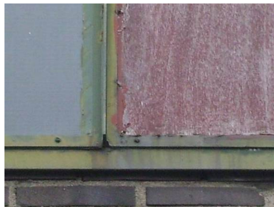
Foto 2: Hal E, detail raamconstructie met asbesthoudende kit daar waar het raamkozijn op de constructie is vastgezet (zie AVH2).
