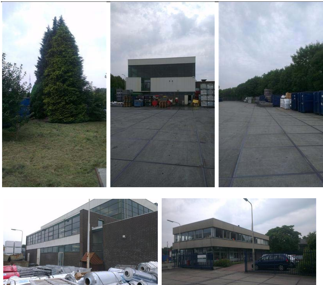
Figuur 2.2 Foto impressie van het plangebied met de kleine loods (huidige technische ruimte) (midden boven & links onder), het kantoorgebouw (rechts onder), het stuk groen aan de oostzijde (links boven) en de bomenrij aan de Kerspellaan (rechts boven).
