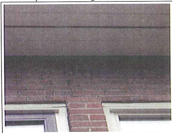
Foto 21: open ventilatie voegen
