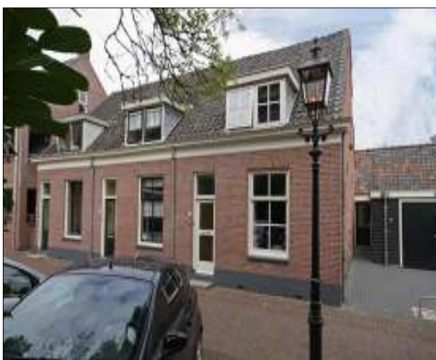
Straatbeeld, belendende bebouwing
