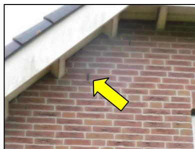
Figuur 18. Openingen in spouwmuur.
