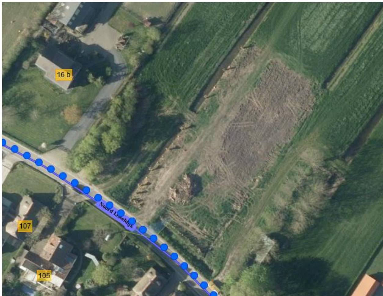
Figuur 2b. Luchtfoto 2016. De vervallen bebouwing is verwijderd. Er ligt een hoop bouwmetaal nabij de inrit. (Bron: Cyclomedia)
