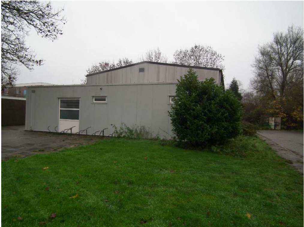
Figuur 3 De achterkant van het zuidwestelijk gelegen gebouw.
