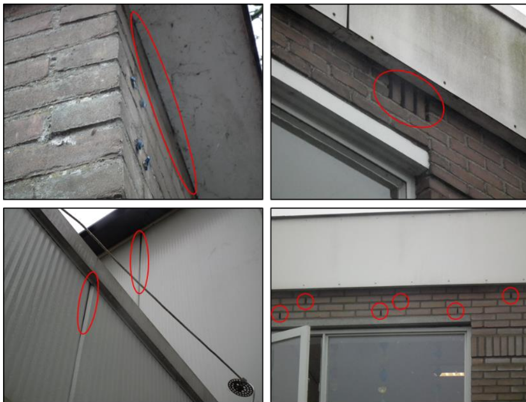
Figuur 3 De schoolgebouwen bevatten veel potentiële openingen welke mogelijk leiden tot de spouwruimte waarvan vleermuizen gebruik kunnen maken Vaste rust- en verblijfplaatsen ten aanzien van vleermuizen kunnen niet uitgesloten worden. (bron: Rebergen, 2018).
