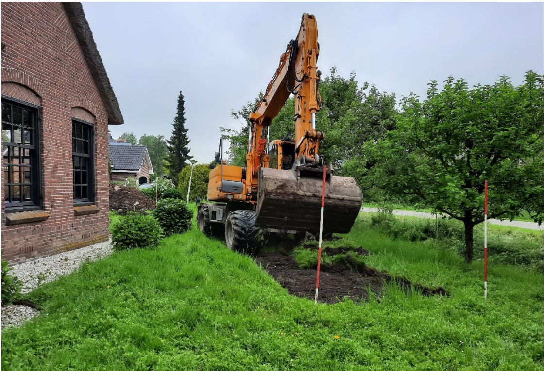
Figuur 2. De aanleg van werkput 2. De werkruimte was hier beperkt.
