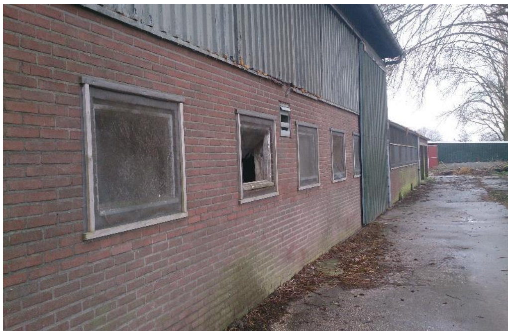
Figuur 2 De voormalige geitenschuur is opgetrokken uit gemetselde muren, een gedeelte met damwandplaten en een golfplaten dak.
