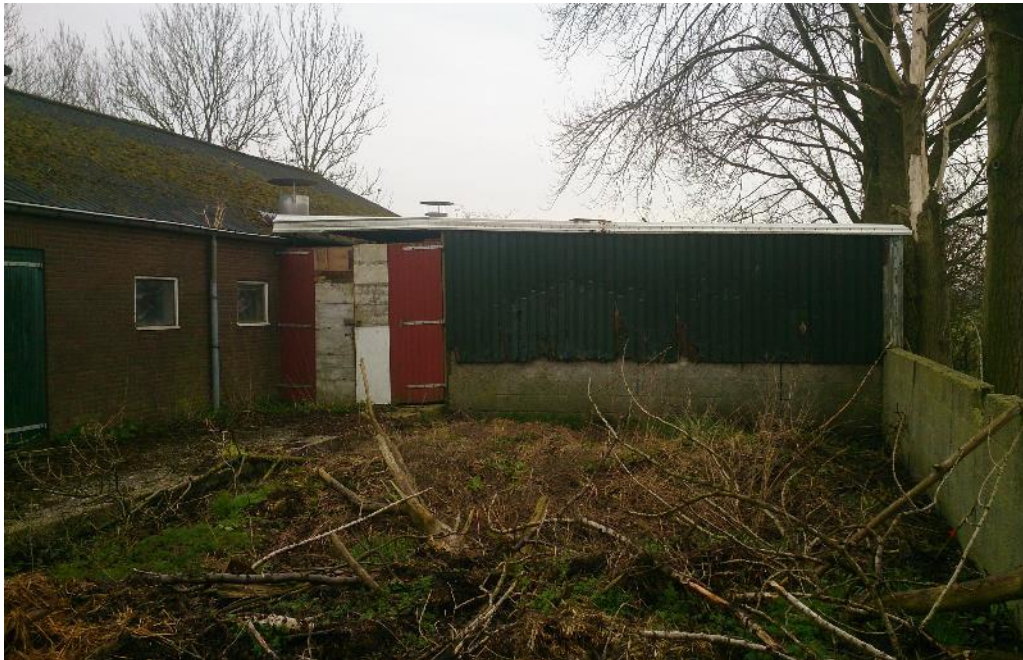
Figuur 3 De aanbouw maakt ook deel uit van het perceel. De aanbouw is opgetrokken uit gemetselde muren, een gedeelte met damwandplaten en een plat bitumen dak.
