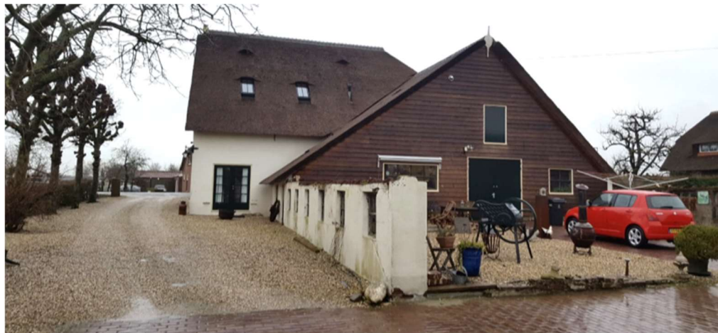
Figuur 4.1. Gedeeltelijk herbouwde boerderij met houten achtergevel en resterende stenen muren van het achterhuis.
