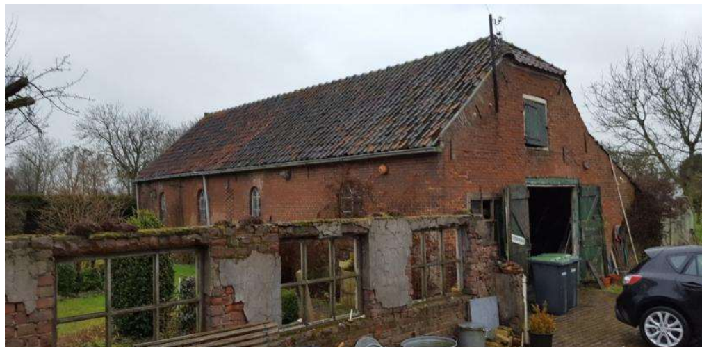
Figuur 4.2. Stenen schuur met op de voorgrond de voormalige contouren van de afgebrande boerderij
