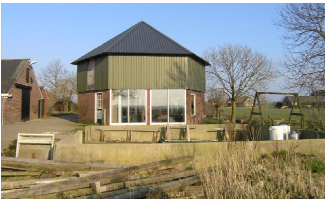
TE SLOPEN BETONNEN SILO (21 FEBRUARI 2018)
