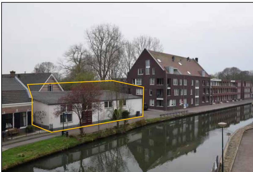
Afbeelding: aanzicht bestaande bedrijfsbebouwing aan de Panoven 23 te IJsselstein (geel omkaderd)
